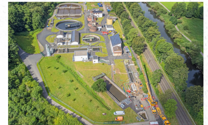
Luftbild der Kläranlage Eitorf beim Einbau einer Feinrechenanlage (Quelle: Fa. Finger-Beton; 2024)
