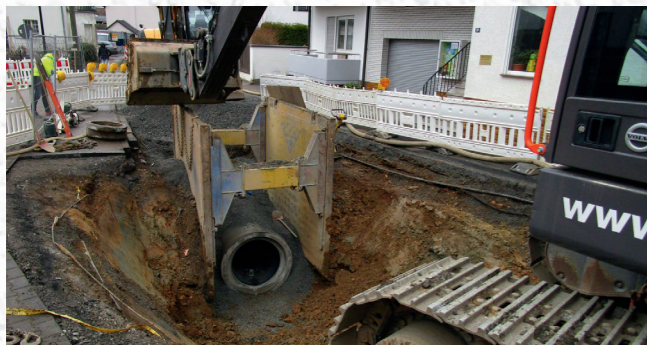
Erneuerung des Kanalnetzes (Quelle: Gemeindewerke Eitorf)
