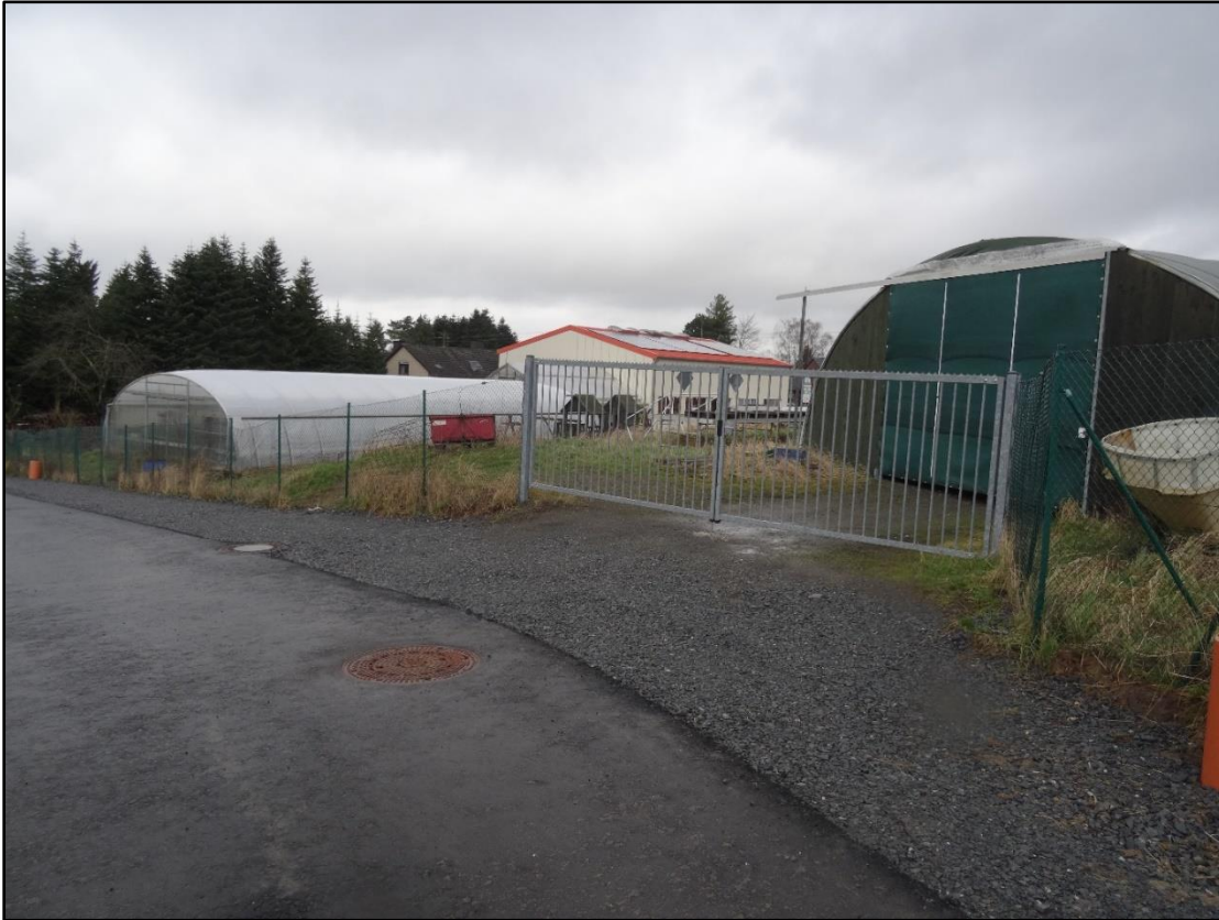
Abbildung 8: Lagerhalle mit Einfahrt, Blickrichtung Norden
